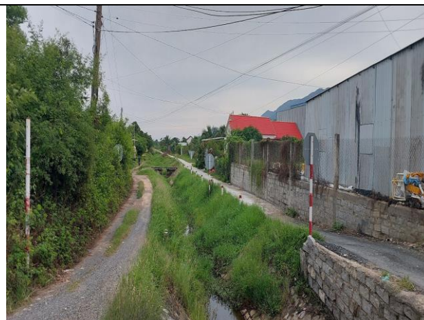
Mương thoát nước hiện trạng giao cắt với tuyến
