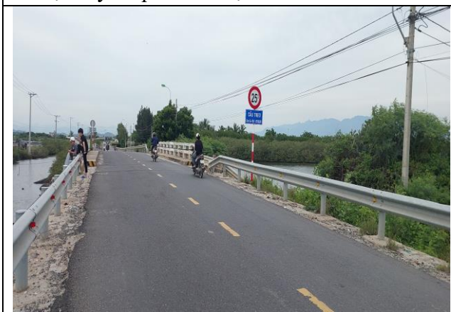
Cầu Treo tại Km6+750
