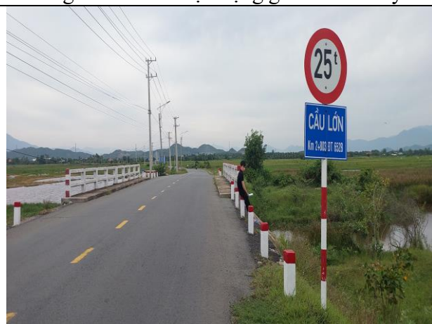
Cầu Lớn, Km2+803/ĐT652B
