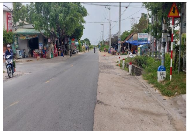
Đoạn tuyến qua KDC đông đúc tại Km4+000
